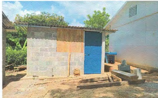
Foto 2: MEJORAMIENTO Y AMPLIACION DE ESTRUCTURA DE LAVAMANOS.
