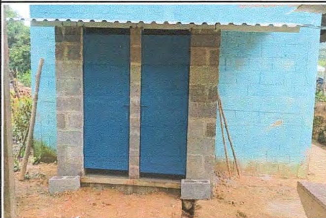
Foto 4: MEJORAMIENTO Y AMPLIACION DE SERVICIOS SANITARIOS
