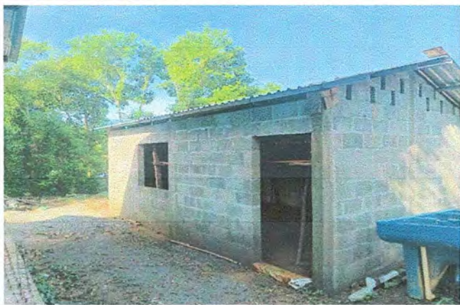
Foto 3: Reparación o sustitución de area de cocina.
