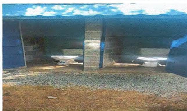
Foto 2: MEJORAMIENTO Y AMPLIACION DE SERVICIOS SANITARIOS
