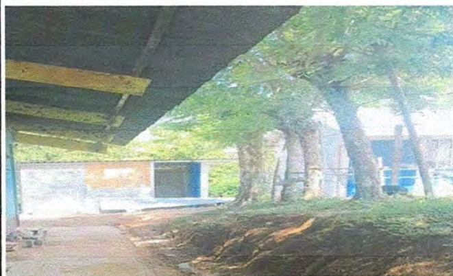
Foto 1: MEJORAMIENTO Y AMPLIACION DE ESTRUCTURA DE LAVAMANOS.
