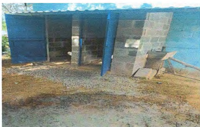
Foto 3: MEJORAMIENTO Y AMPLIACION DE SERVICIOS SANITARIOS
